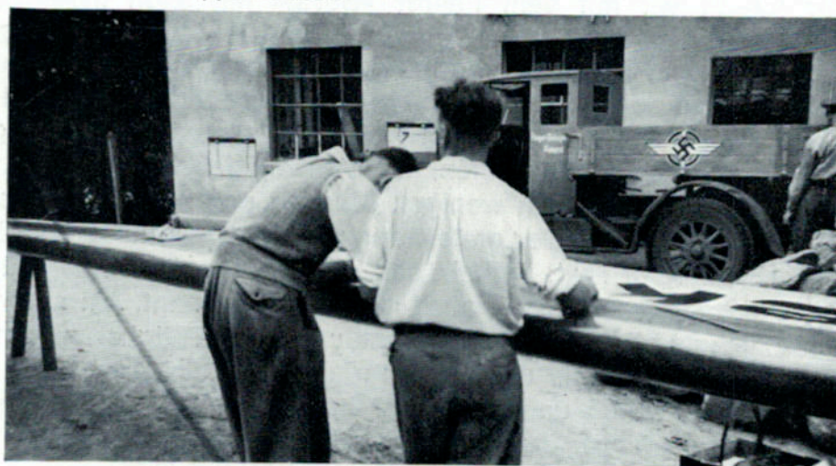
Reparatur unserer »Stadt Schorndorf« im Hof des Flugzeugbau Schleicher in Poppenhausen
