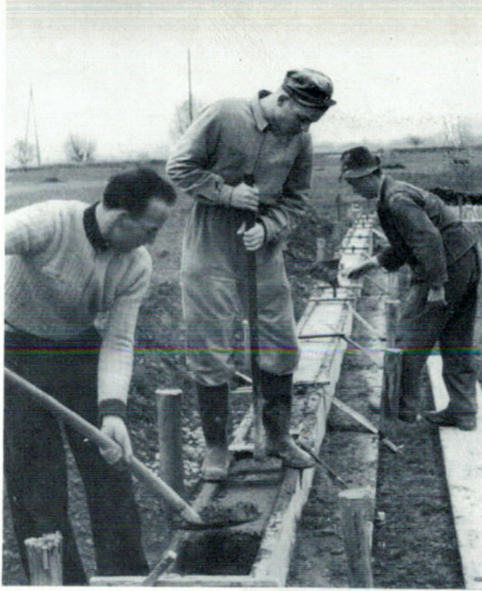
Bau der Fundamente für das neue Fliegerheim
